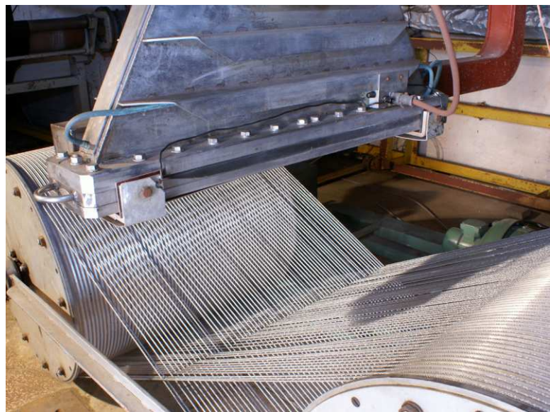
Fot. 1. Fragment akceleratorowej instalacji do radiacyjnego sieciowania izolacji kabli elektrycznych. Powyżej skaner przemiatający wiązkę elektronów na szerokość przewijanych na walcach kabli
