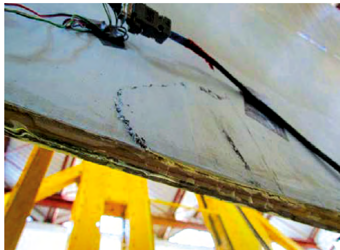
Fot. 3. Zniszczenie laminatu dolnego dźwigara (widoczny czujnik DFOS oraz tensometr)
