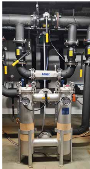
System z wymiennymi wkładami filtracyjnymi montowany w bajpasie na zbiorniku buforowym wody
