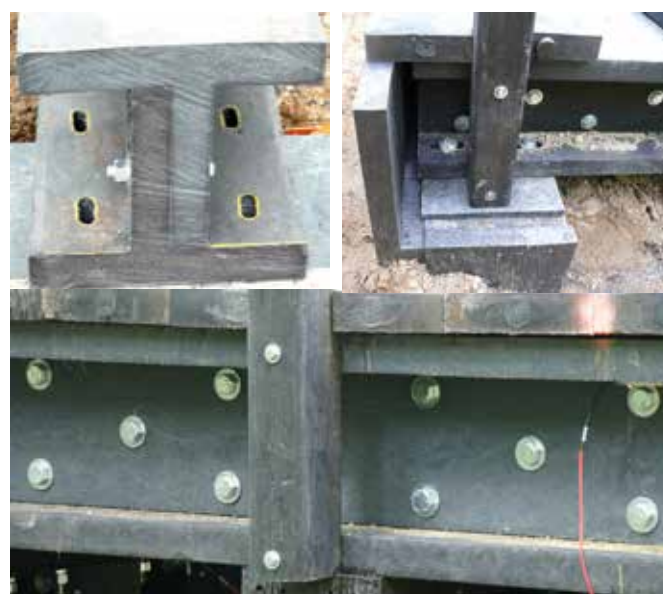
Rys. 1. Główne elementy systemu Axion's STRUXURE Construction System: a) dźwigar główny - przekrój; b) dźwigar główny - widok z boku; c) podparcie dźwigara na podporze
