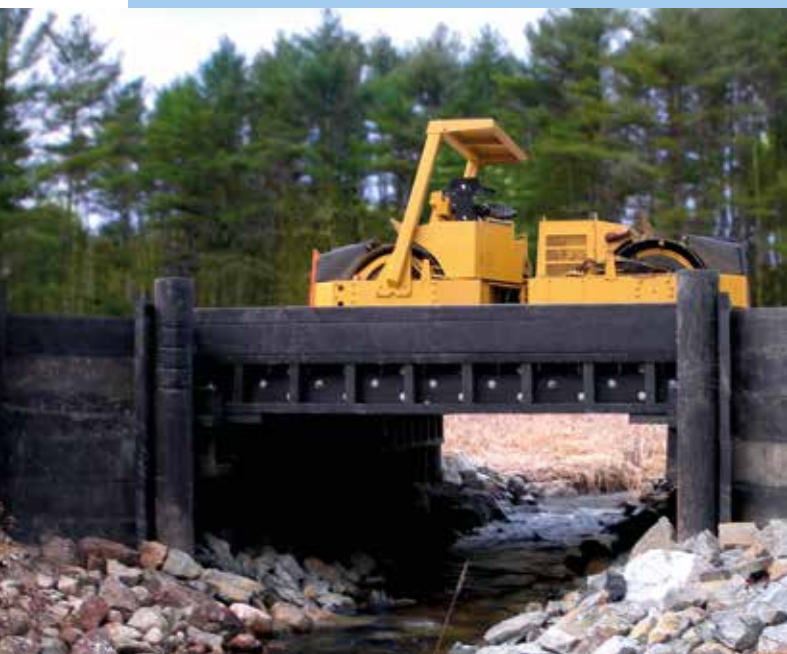
Rys.6. Pierwszy most z kompozytów RTC położony w ciągu amerykańskiej sieci dróg publicznych, York, Maine, USA
