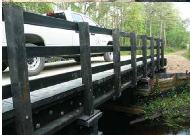
Rys.4. Jeden z mostów z kompozytu RTC w Fort Bragg, USA: a) elementy podpór; b) gotowy most
