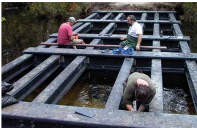
Rys.3. Ruszt przęsła mostu w Wharton State Forest, USA, wykonany z dwuteowych belek z kompozytu RTC
