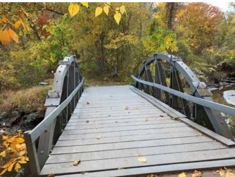
Rys.2. Pierwszy na świecie most wykonany z kompozytu RTC, New Baltimore, USA
