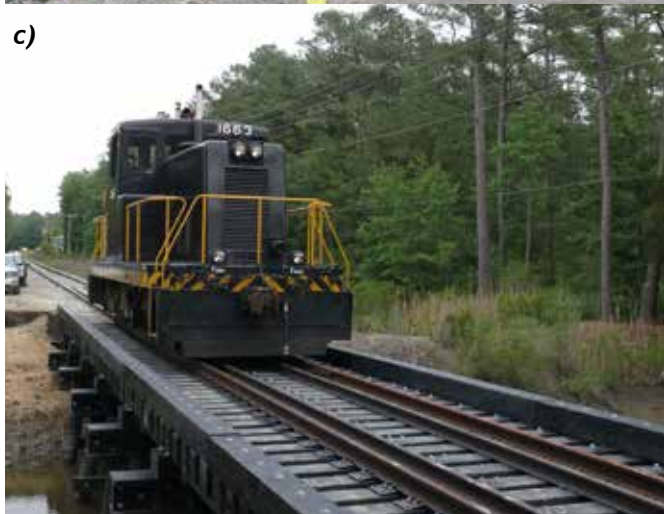
Rys.5. Pierwszy na świecie most kolejowy z kompozytu RTC w Fort Eustis, USA: a) grupy belek dwuteowych; b) ustrój nośny; c) most pod próbnym obciążeniem lokomotywą
