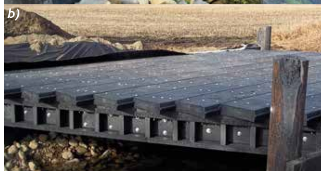
Rys.7. Jednoprzęsłowy most zintegrowany z kompozytu RTC Onion Ditch Bridge, Ohio, USA: a) widok ogólny; b) zoptymalizowane materiałowo deski pomostowe łączone na pióro i wpust
