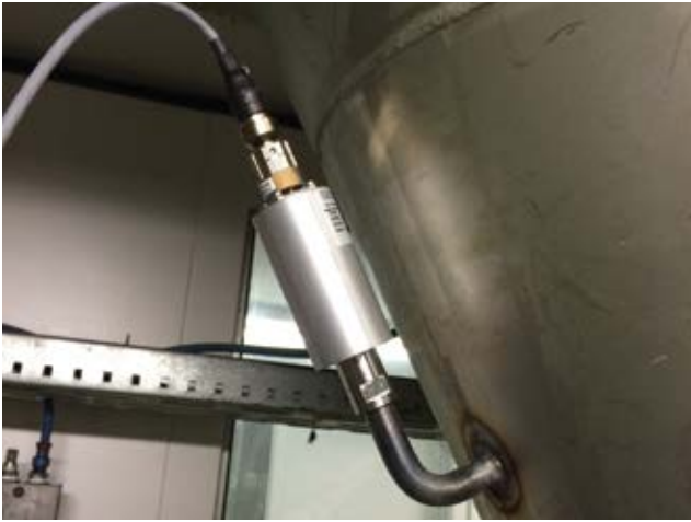
Ultradźwiękowy system udrażniania silosu. Na zdjęciu głowica ultradźwiękowa. Źródło: Inżynieria Pro
