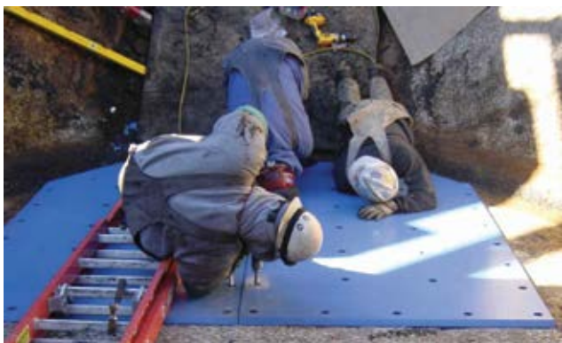
Montaż paneli okładzin ściennych silosu. Źródło: QUADRANT EPP POLSKA
