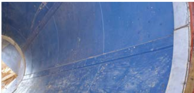
Lej wysypowy silosu obłożony okładzinami w systemie TIVAR Engineering. Źródło: QUADRANT EPP POLSKA
